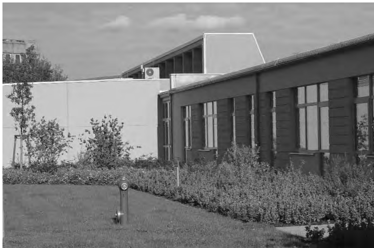
Der Neubau in Hoppegarten. Bild: Bundesarchiv
