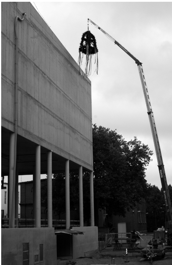
Die Richtkronen wird aufgezogen.
