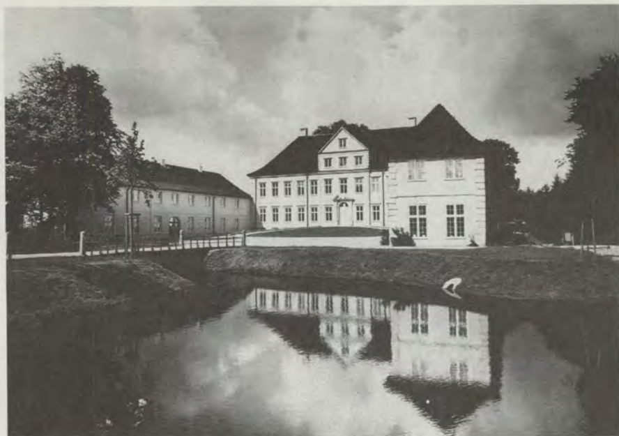
Abb. 1: Blick von Osten über die wiederhergestellte Teich- und Brückenanlage auf das restaurierte „Prinzenpalais“ mit dem Ehrenhof, den Werkstätten im Süd- und den Dienstwohnungen im Nordflügel.
