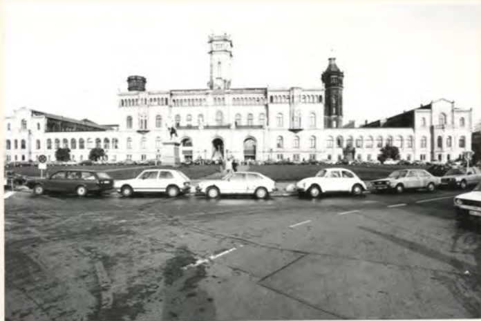
Ansicht des Hauptgebäudes von der Nienburger Straße aus gesehen (Standort 1)
